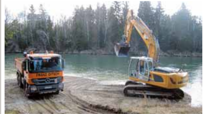
Gewässerschutzmaßnahmen an der Lechstaustufe 20 bei Scheuring.
