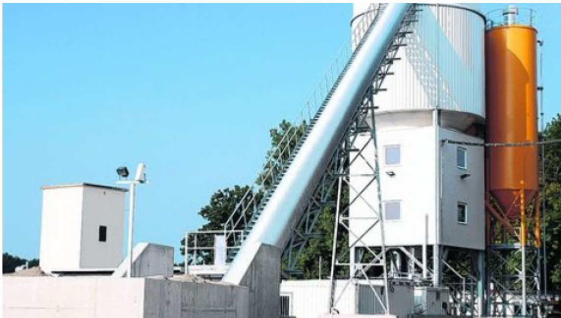
1,5 Millionen in neues Betonwerk investiert
